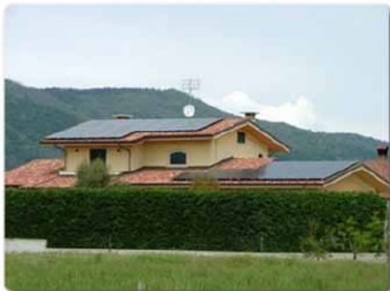
Impianti su edifici
